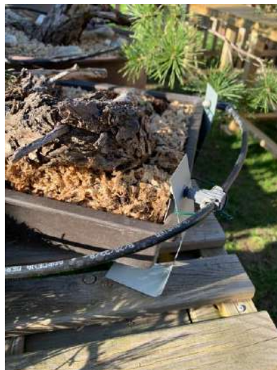
Détail de la mise en de plusieurs brumisateurs
